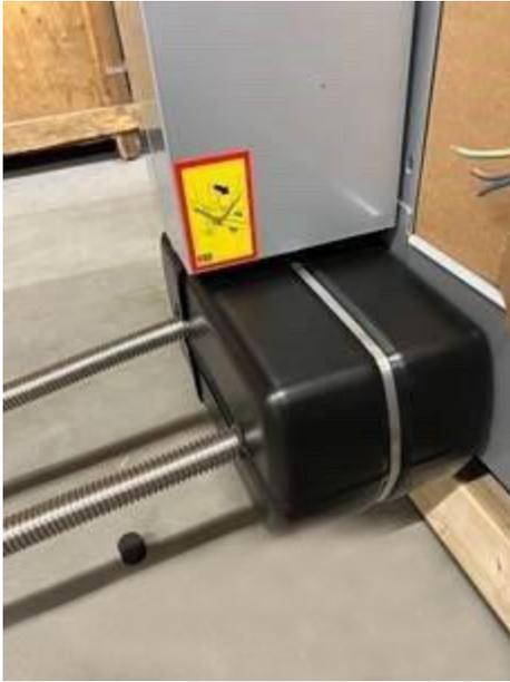
7. Erste Isolierung an den Rohren anbringen
