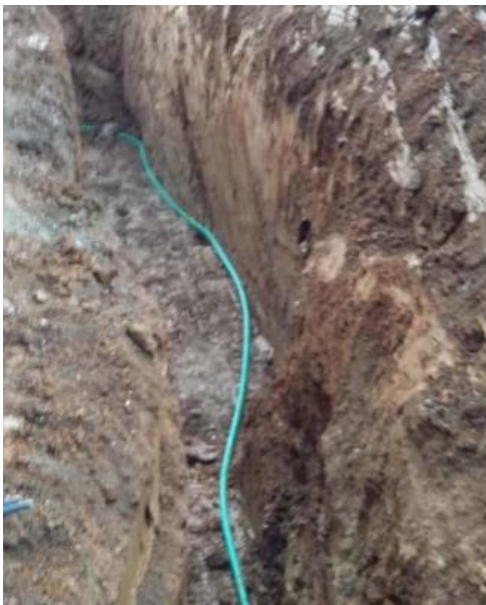
Verlegen des Anbindeleitungsabschnitts im dafür vorgesehenen Rohrgraben.
