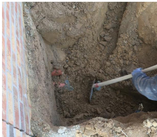
Freibaggern der Palette von der Rückseite und Herstellen des Grabenabschnitts für die Hauseinführung.
