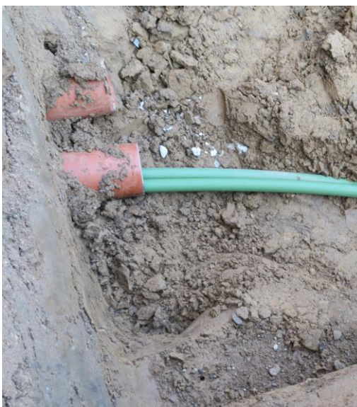
Verlegen des Anbindeleitungsabschnitts im dafür vorgesehenen Rohrgraben.
