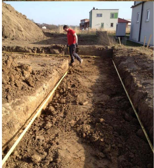
Verlegung Trassenwarnband seitlich im oberen Bereich des Kollektorgrabens (z.B. 0,5m unter Geländeoberkante GOK)
