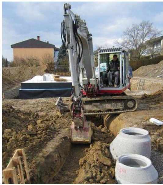
Freibaggern der Palette von der Rückseite und Herstellen des Grabenabschnitts für die Hauseinführung.
