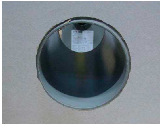
Dämmung bis an die Ausseneinheit schieben (Bild NIBE F2040)
