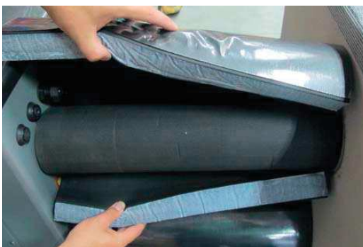
Dämmung bis an die Ausseneinheit (Bild NIBE F2040)
