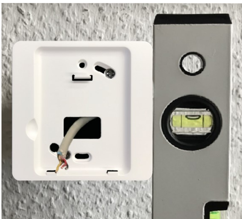
Bild: Auszug Kabeldurchführung
